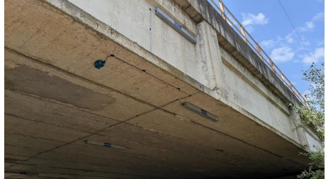
2 Cordes Optiques longitudinales, à mi-travée, en bordure en fibre supérieure : Flexion sous circulation et suivi de la hauteur de l'axe neutre par comparaison avec la mesure équivalente en fibre inférieure.
