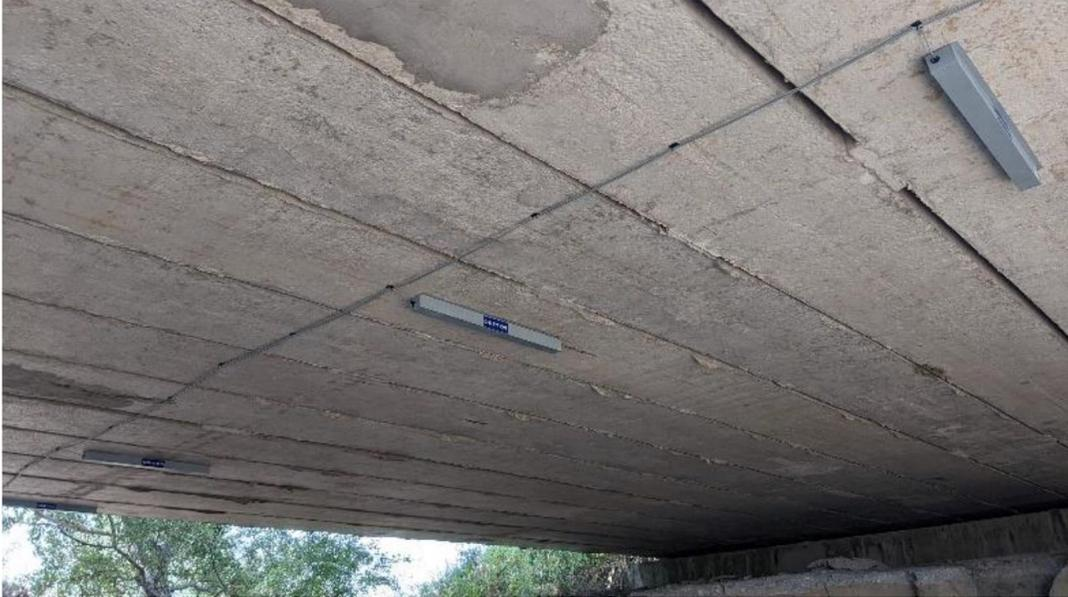
4 Cordes Optiques longitudinales, à mi-travée, en sous-face du tablier, réparties sur la largeur : Flexion sous l'effet des charges de circulation, pesage en marche
