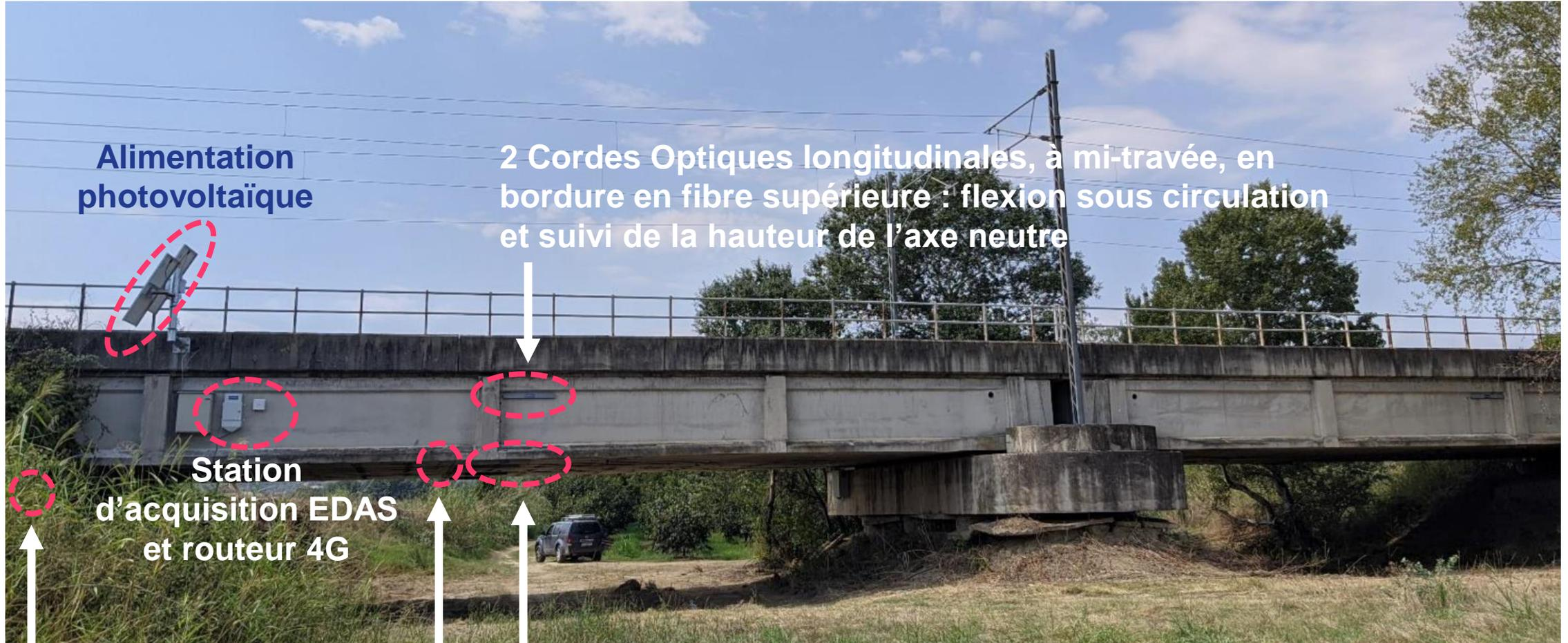
2 Accéléromètres OSMOS AAA (MEMS) sur culée et à mi-travée : comportement sous séisme
