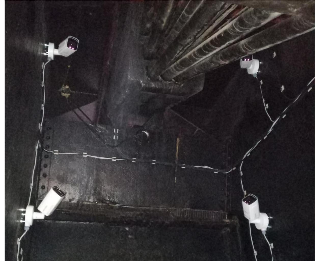
Caméras infrarouges avec éclairage intégré
