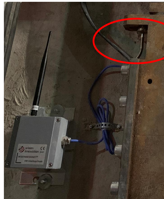
Mesure de la température de l'appareil de dilatation par un capteur magnétique connecté à un nœud WiSen VW 1 port
