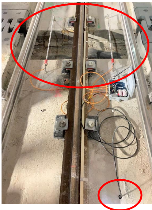
Fissuromètres et capteur de température coulé dans le béton Connectés sur un nœud WiSen VW 4 ports
