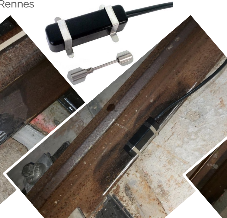
Positionnement du carter de protection et de la corde vibrante
