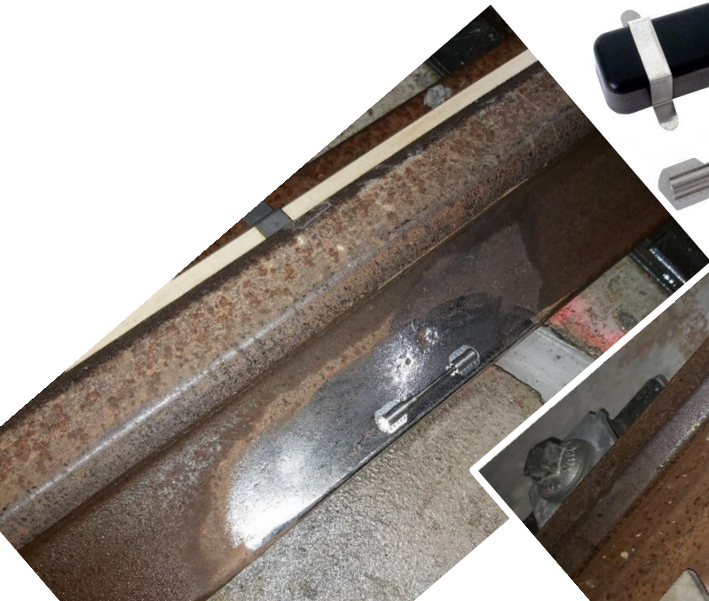
Soudure de la jauge de contrainte sur le rail de guidage
