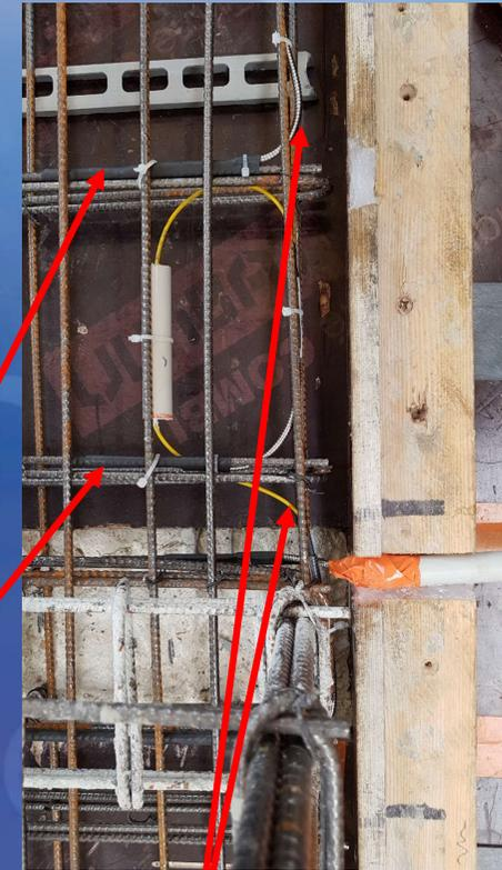
Jarrettières de concaténation des capteurs à Fibre Optique
