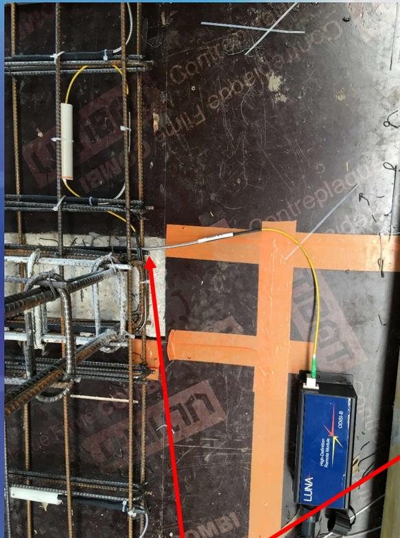
Sortie de la Fibre optique vers le Boitier d'interconnexion
