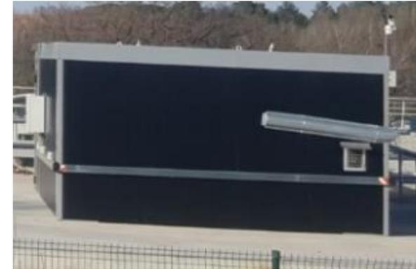
*Local d'étuvage pour la réalisation des traitements thermiques sur les blocs RSI.*
